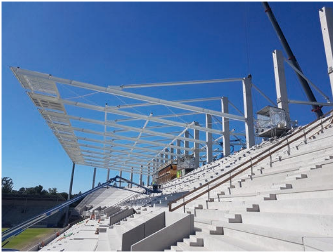
Bild 8 Primärkonstruktion der Dachelemente mittels Mobilkran und Hubsteiger Primary construction of the roof elements by means of mobile crane and cherry picker
