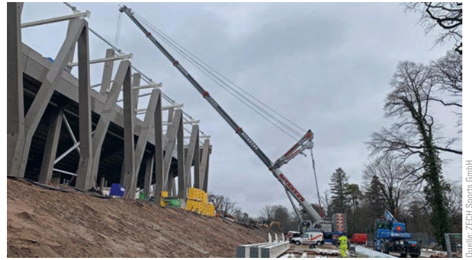
Bild 7 Winter 2021: die Y-Stützen erwachen zum Leben Winter 2021: the Y supports come alive
